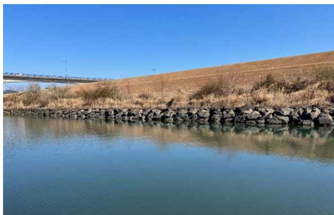
写真4 中筋川の下流域の渡川大橋付近。石積みで河川の沿岸を補強している。
