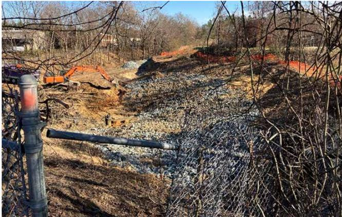
写真1 地下に埋まっていたパイプを掘り起こし、撤去して、其処に水流；ストリームの水位を上昇させるための木材チップスと小石などを敷設 2022年12月2日著者撮影
