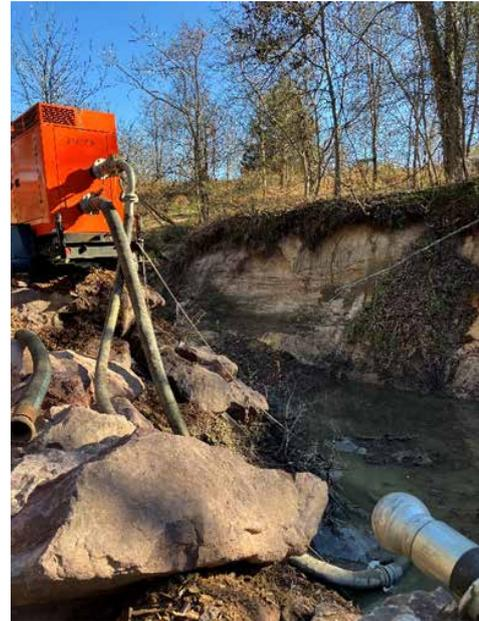
写真2 埋設されたパイプを撤去した後では、其処にストーム水が表面に現れるので、これをポンプで水を抜き取る 2022年12月2日著者撮影
