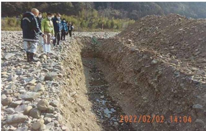
写真4 江川崎岩間沈下橋付近の河川敷の掘削 伏流水がない
