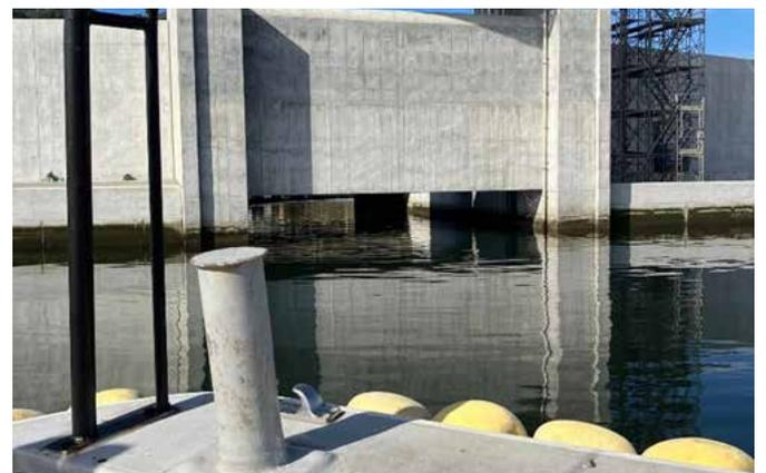
写真2 大船渡湾に排水処理場から処理水が流れ出る排水口
