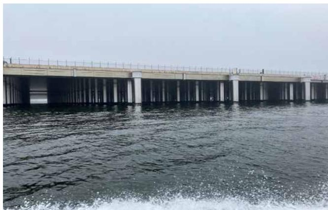
写真2 羽田空港のD滑走路 円柱。流速停滞の可能性。
